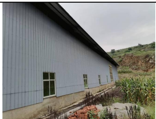
照片 2 建构筑物区现状
