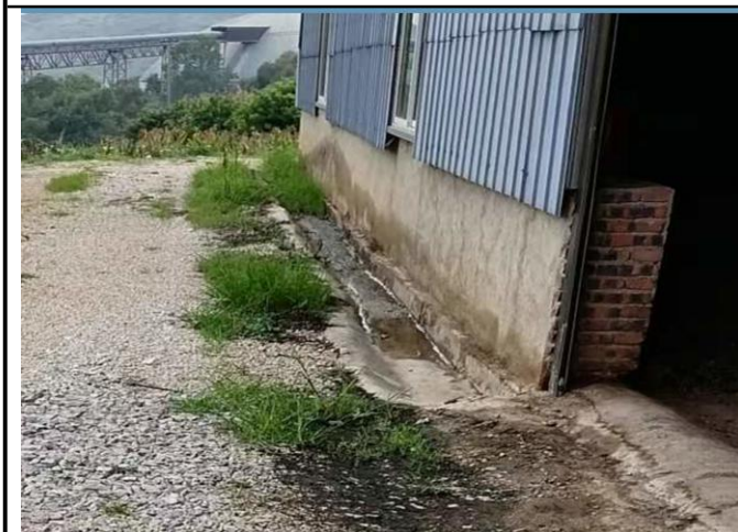
照片 5 建构筑物周边排水明沟现状
