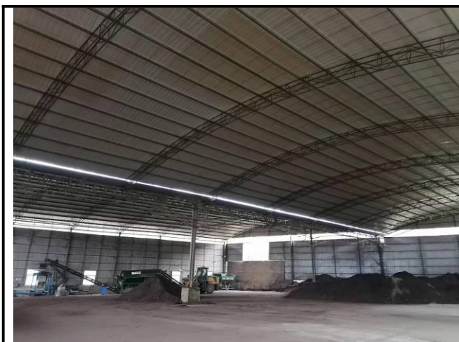
照片 1 建构筑物区现状
