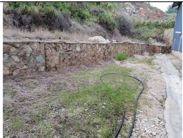
照片 6 项目区北侧浆砌石护坡挡墙现状
