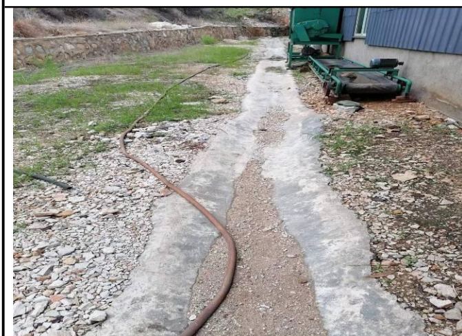
照片 3 建构筑物周边排水明沟现状
