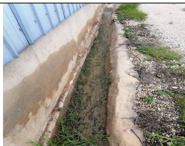
照片 4 建构筑物周边排水明沟现状
