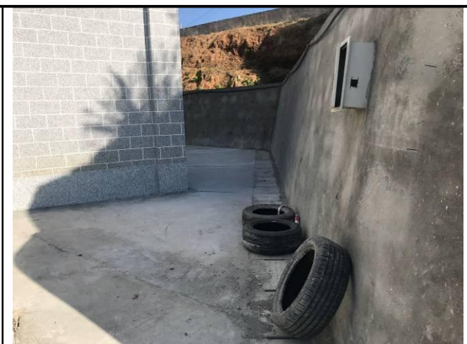
照片 5 办公楼周边盖板排水沟现状
