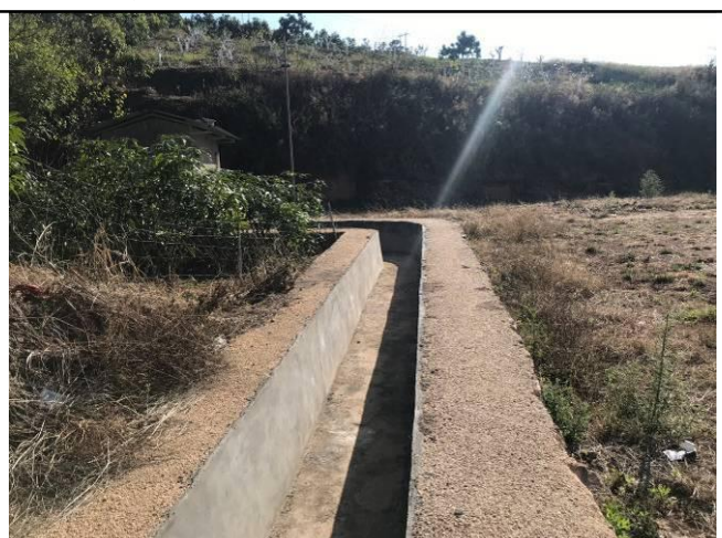
照片 19 场地东侧排水明沟现状
