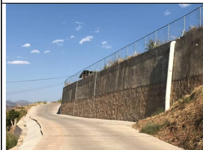
照片 18 场地北侧浆砌石护坡挡墙及 PVC 排水管现状
