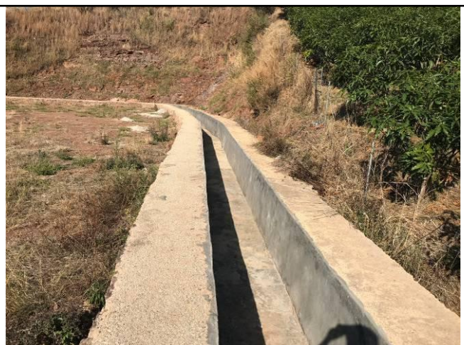
照片 21 场地东侧排水明沟现状
