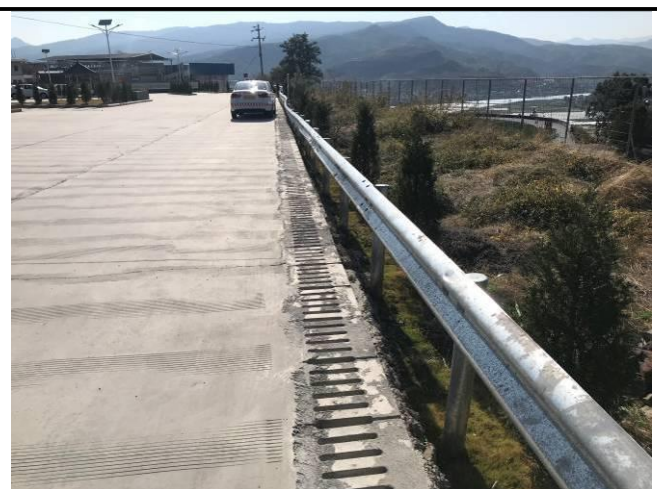
照片 11 场地周边盖板排水沟现状
