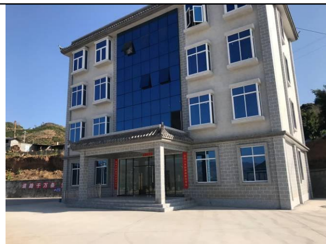
照片3 办公楼现状
