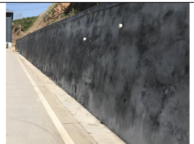
照片 15 场地南侧浆砌石护坡挡墙现状
