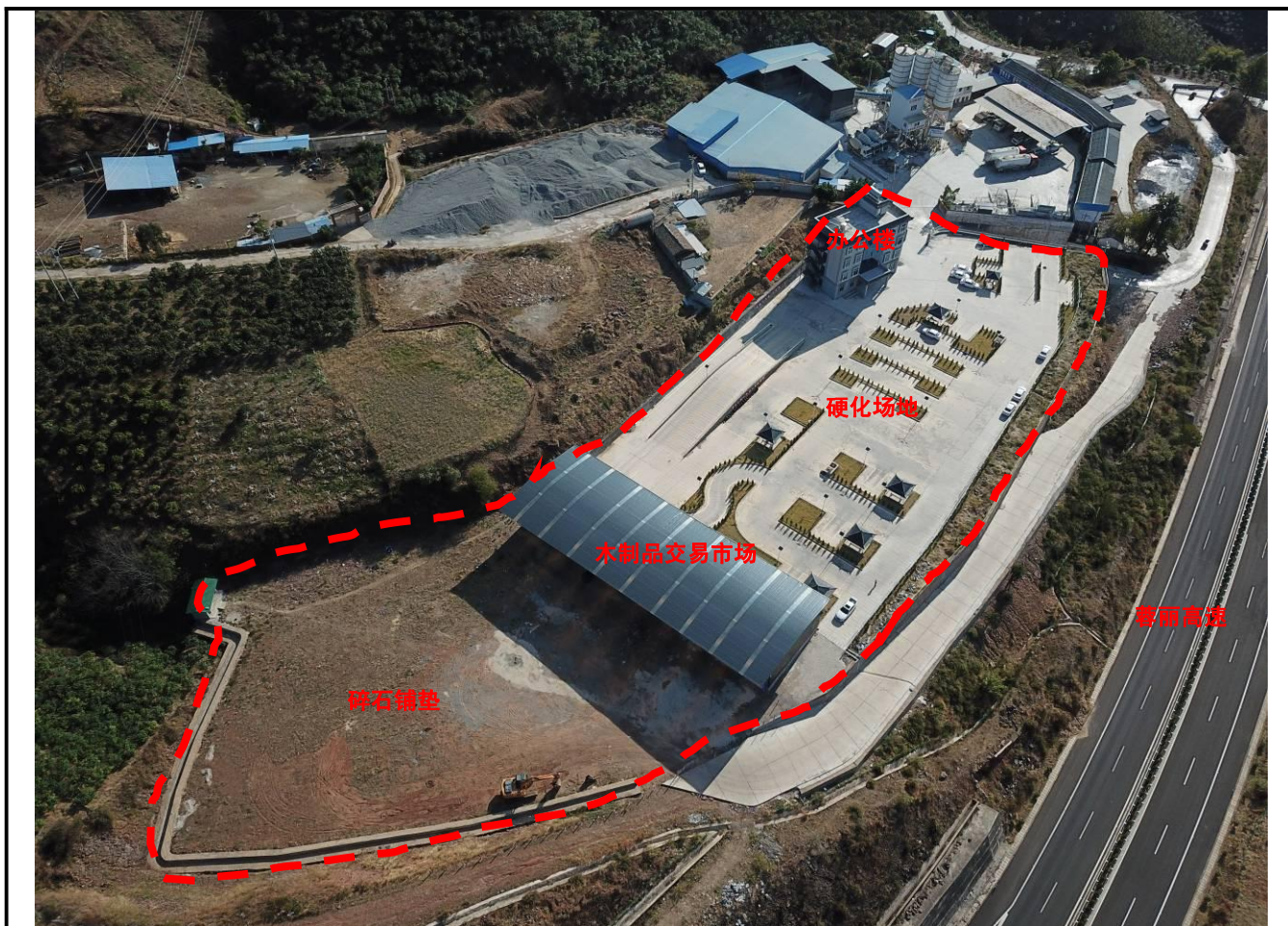
照片1 项目区航拍全貌现状
