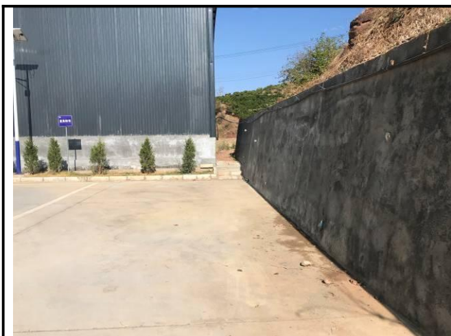
照片 16 场地南侧浆砌石护坡挡墙现状
