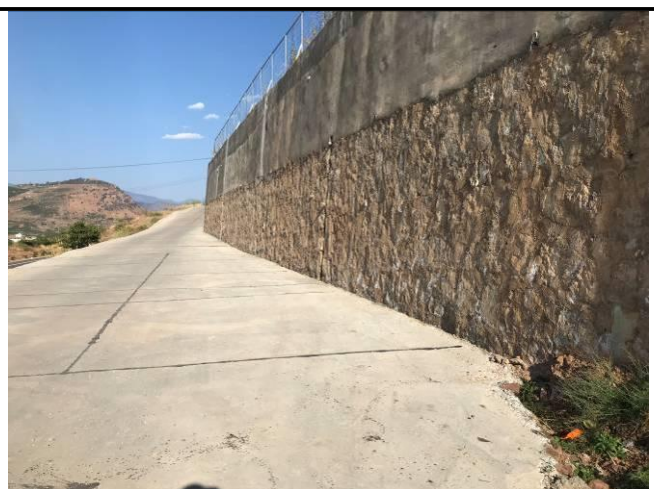
照片 17 场地北侧浆砌石护坡挡墙现状
