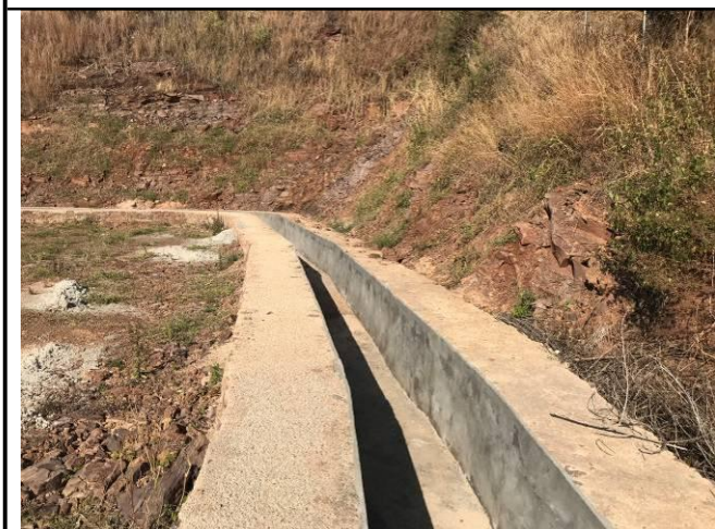
照片 20 场地东侧排水明沟现状
