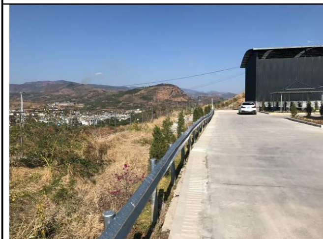
照片 14 场地周边盖板排水沟现状
