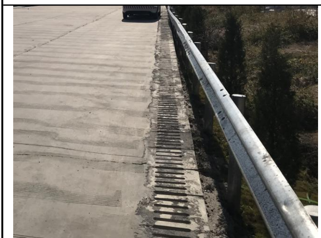
照片 12 场地周边盖板排水沟现状
