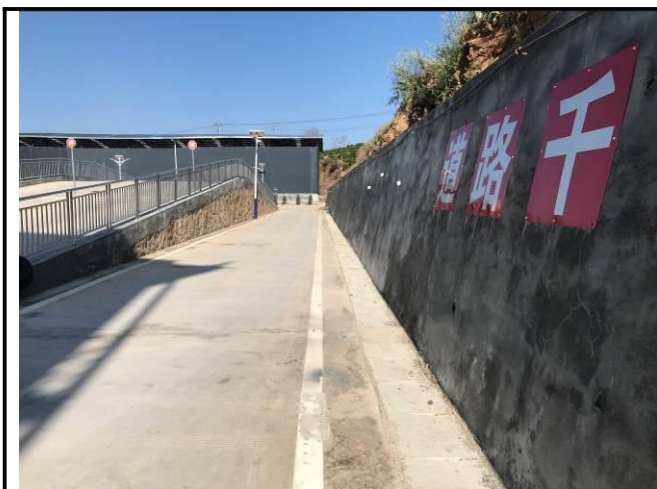
照片 10 场地周边盖板排水沟现状
