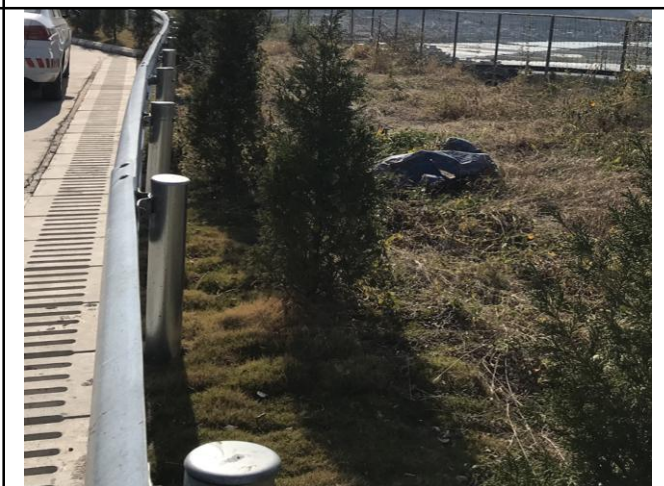
照片 9 场地周边盖板排水沟现状
