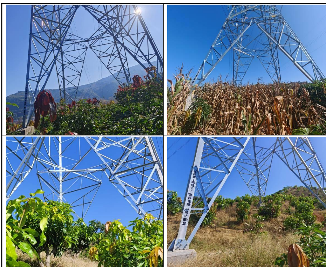
图 1-2 塔基施工场地现状情况（2023 年 10 月）
