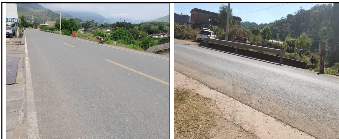
图 1-4 跨越施工场地现状情况（2023 年 10 月）
