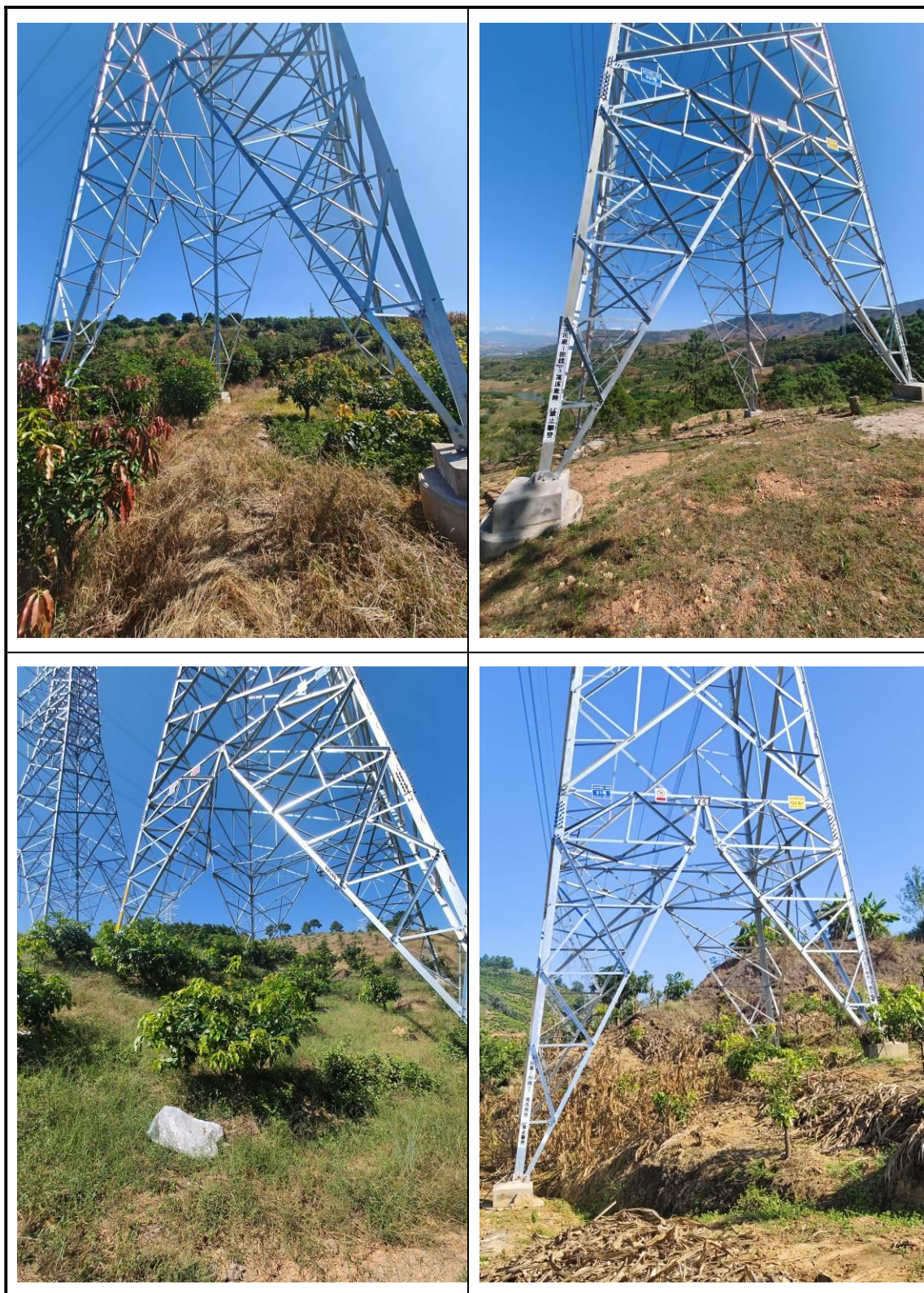
图 1-1 塔基现场照片（2023 年 10 月）
