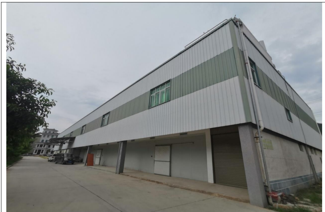
图 1-3 建构筑物区现状（2023 年 7 月）
