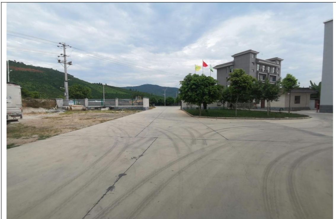
图 1-5 道路场地区现状（2023 年 7 月）
