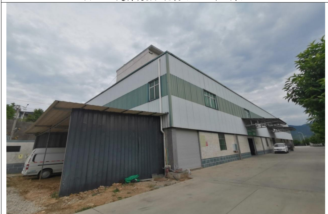
图 1-4 建构筑物区现状（2023 年 7 月）
