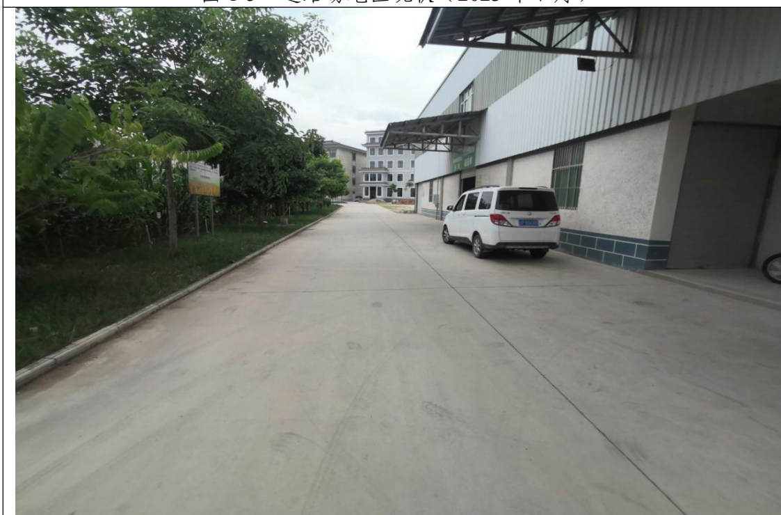
图 1-6 道路场地区现状（2023 年 7 月）
